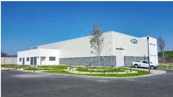
Bild 5: 650 Quadratmeter groß ist die Fertigungshalle im neuen Werk in Querétaro. Für Service und Vertrieb steht ein zweigeschossiger Verwaltungstrakt zur Verfügung.
