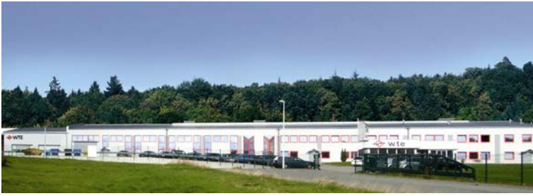
2009-03-08, Bild 1: Das Produktionsgebäude von WTE Präzisionstechnik GmbH in Ehrenfriedersdorf
